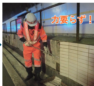
③ケレン棒をタイルの背面に差込むとタイルが簡単に剥がれ落ちます
