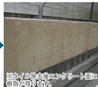
④落下したタイルを除去して 作業完了
