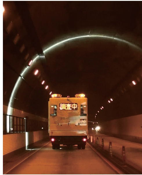
トンネル覆工面調査画像
