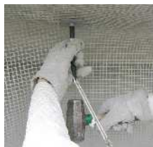
打ち込み棒とハンマーで打設
