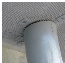
配水管周辺も施工が容易
