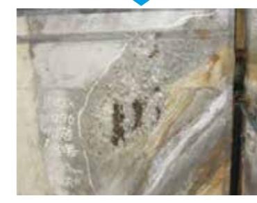
打音点検結果→コンクリート剥離部撤去
