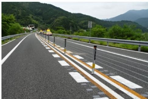
暫定供用区間に中央帯にワイヤロープ式防護柵LD種（レーンディバイダ）が設置されました。ワイヤロープ式防護柵は、対向車線へのはみ出し防止と衝突車両への衝撃緩和に有効な防護柵です。
